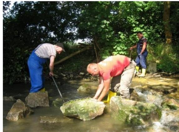
Abbildung 39: Gewässerentwicklung - Bau einer Sohlgleite
