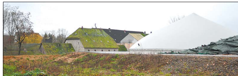
Die Biogasanlage Eichholz soll Energie für Steinheim spenden. Foto: Ilding
