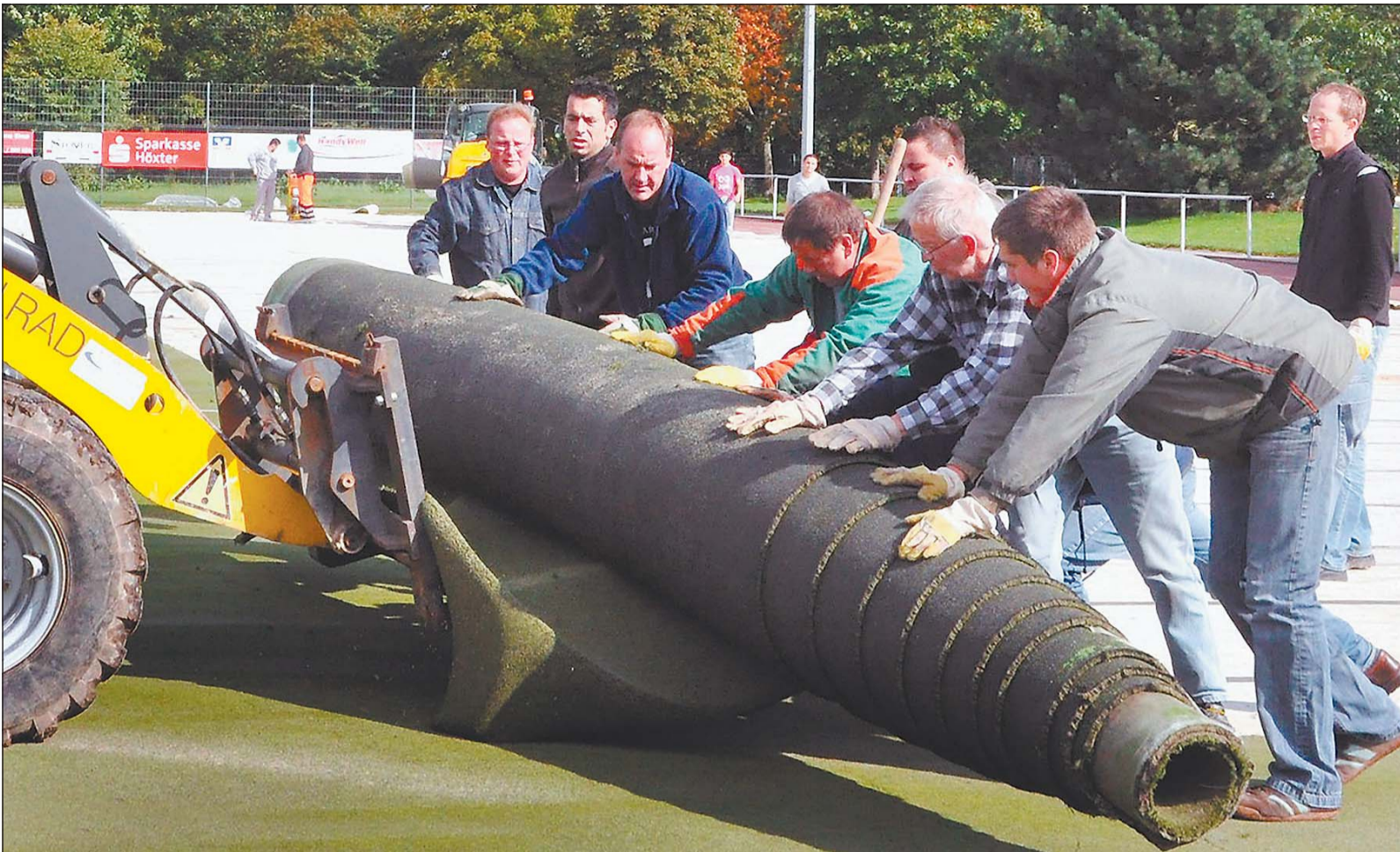
Steinheimer Vereine helfen bei der Sanierung des Kunstrasenplatzes: darunter Bauamtsleiter Friedhelm Borgmeier (3. von links) und sein Stellvertreter Alexander Frewer (hinten rechts). Jede der Rollen wiegt etwa eine Tonne – hier die freiwilligen Helfer, Foto: Heinz Wilfert
