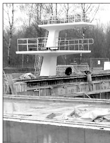
Das Freibad in Steinheim wird derzeit umfassend saniert.
