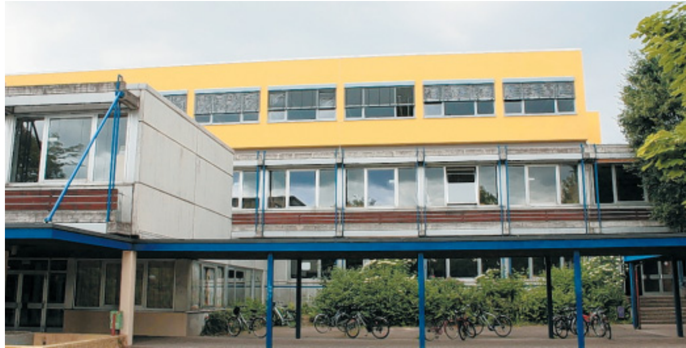
Aufgestockt: Der gelb gestrichene Erweiterungsbau bildet mit sechs neuen Klassenräumen die dritte Etage am Gymnasium in Steinheim.
