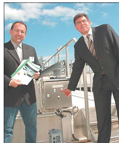
Mit einem Druck auf den roten Knopf gibt Steinheims Bürgermeister Joachim Franzke den Startschuss für die erneuerte Kläranlage. Links: Michael Bickel vom Planungsbüro Hydro Compact.
