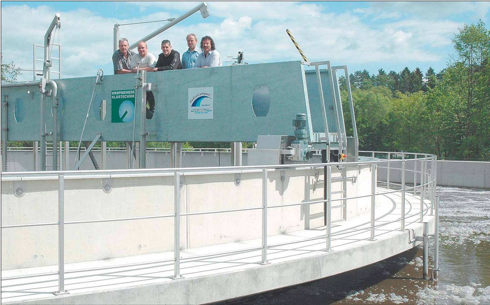
Die fünf Ver- und Entsorger auf dem Kommandostand, der Brücke des neuen Kombi-Belebungsbeckens mit einem Durchmesser von 48 Metern:
