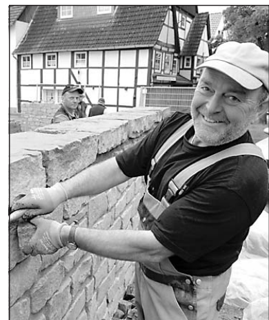
Rainer Graute und seine Kollegen haben für den neuen Biergarten in der Kernstadt eine Bruchsteinmauer errichtet. Foto: H. Iding
