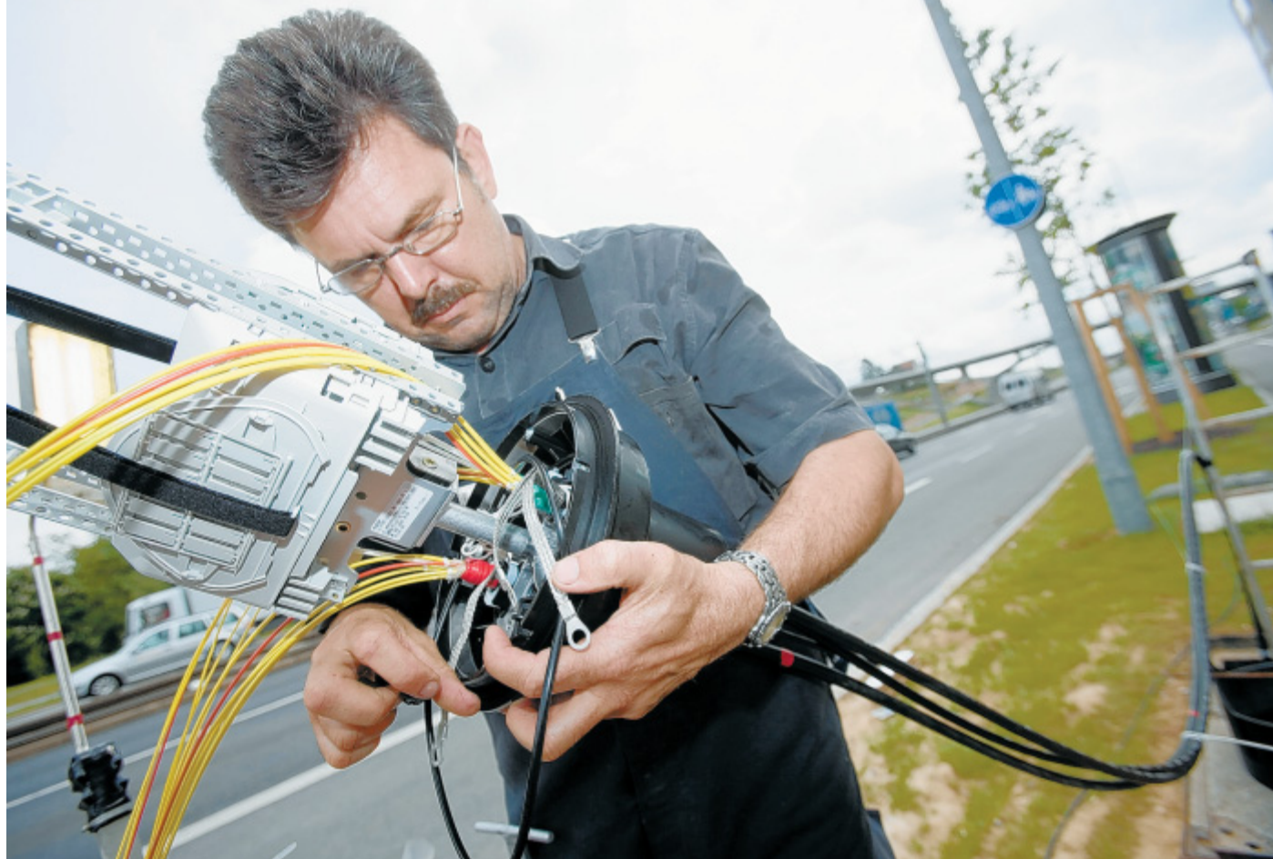
Bei der Arbeit: Wie auf diesem Foto soll demnächst auch in allen Ortschaften des Kreises Hörter durch neue Breitbandkabel die Internetautobahn staufrei gemacht werden. Der Kreis Hörter hat gestern das neue Konzept vorgestellt.
