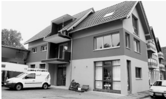
Außenansicht: Die letzten Arbeiten am und im Nox stehen kurz vor der Vollendung.
