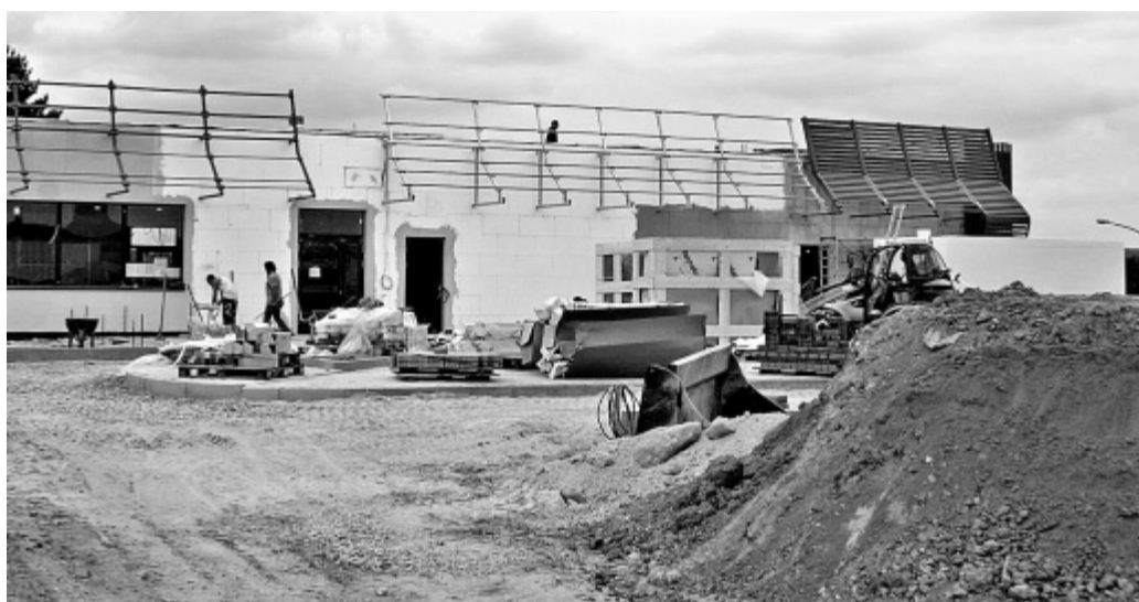
Es geht voran: Die McDonald's-Filiale in Steinheim wird nach dem gleichen Prinzip gebaut wie fast alle der 1.361 anderen Fast-Food-Restaurants der Kette. FOTO: KAROLINE DÜWEL
