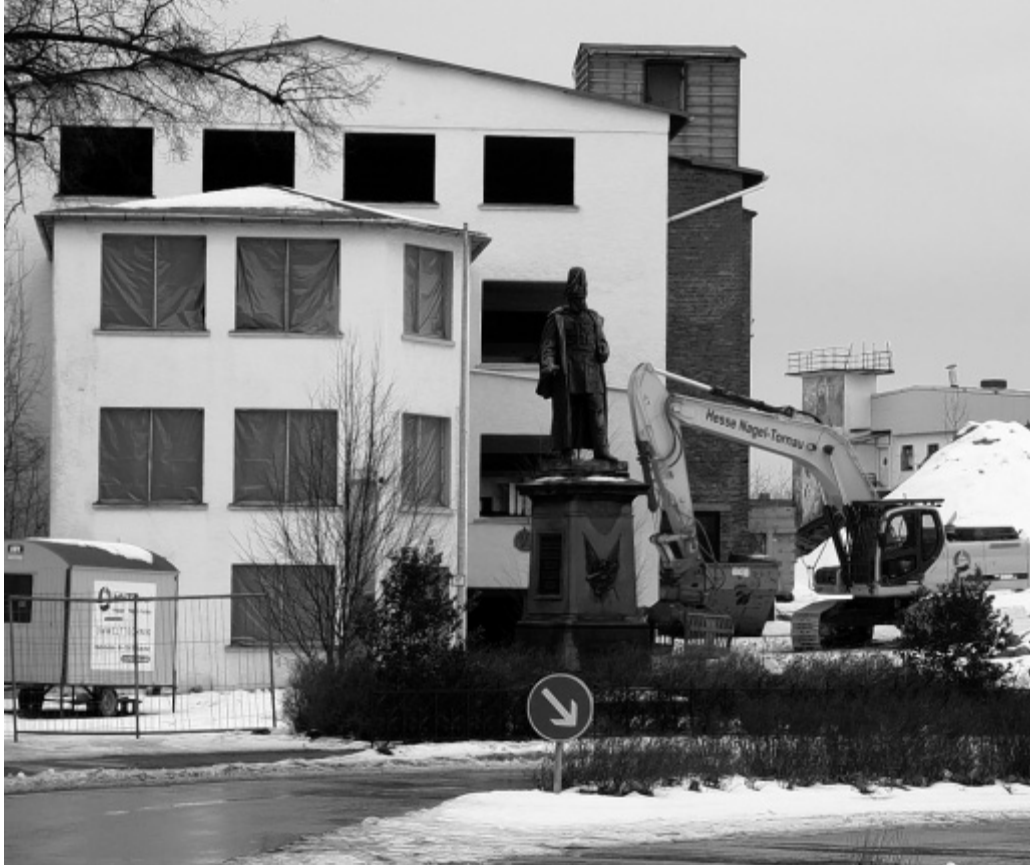
Eines der großen Objekte: Blick auf die Sanierung eines Industrie-Reliktes; die ehemalige Möbelfabrik wird ein Gesundheitszentrum beherbergen.
