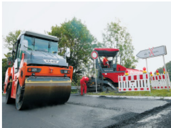
Der Asphalt ist drauf: Nach der Asphaltierung konnte gestern die Zufahrt von der Ostwestfalenstraße ins Gewerbegebiet Nieheim wieder freigegeben werden. In der kommenden Woche soll die Abfahrt nach Holzhausen gesperrt werden.
