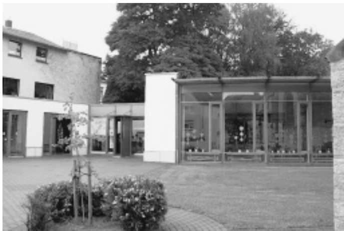
Das Gebäudeensemble: Rechts vorne ist noch ein Stück Kirchenmauer zu erkennen, dahinter der lichte Gemeindesaal des evangelischen Gemeindezentrums mit dem Verbindungsstück zum Altbau links.
