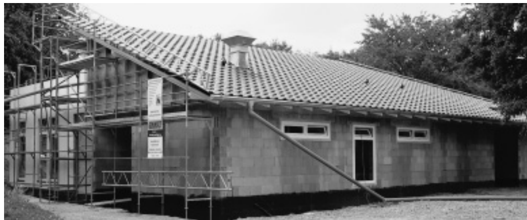
Im Rohbau: So präsentiert sich derzeit die neue Mensa im Schulzentrum Steinheim.
