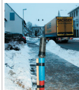
Der Rest: Mehr ist von der Straßenlaterne nach dem Unfall nicht mehr übrig. FOTO: UWE MÜLLER
