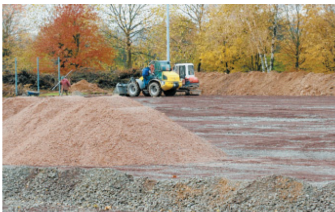
In vollem Gang: Die Bauarbeiten am Kunstrasenplatz am Gymnasium haben begonnen. Auch wenn der Fußballplatz noch nicht zu erkennen ist, soll er schnell gebaut sein.
