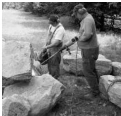
Gut gebohrt, ist halb gewonnen: Hier werden Löcher in die großen Felsbrocken aus dem Steinbruch Altmix (bei Bremerberg) für die Stahlschleife gebohrt.
