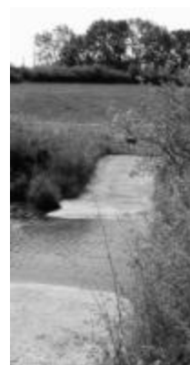
Eine alte Furt neu gebaut: Hier geht's ohne Brücke am Heubach weiter.
