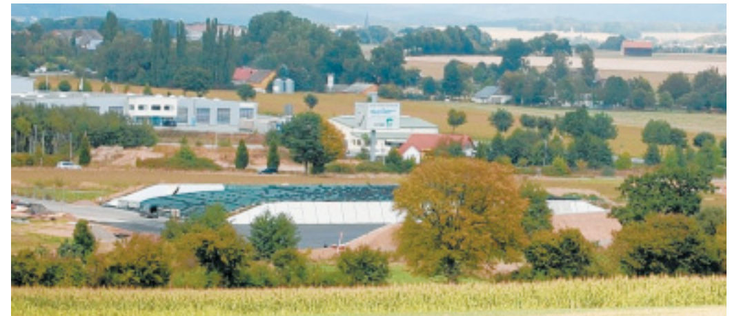
Der Ort, an dem die Biogasanlage gebaut werden soll: Die Silage ist im Vordergrund schon zu sehen.
